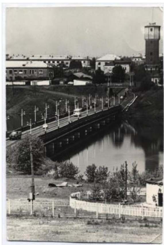
Рис. 13. Водонапорная башня Алапаевского металлургического завода. Вид со стороны Рабочего городка (фото советского периода)
