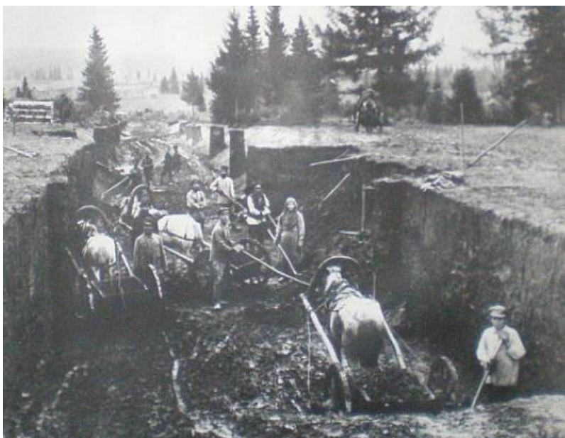
Рис. 20. Строительство узкоколейки (фото 1893-94 гг.)
