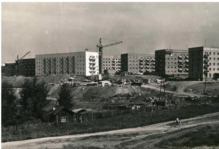
Рис. 25. Строительство на Красном камне, 1968 год
